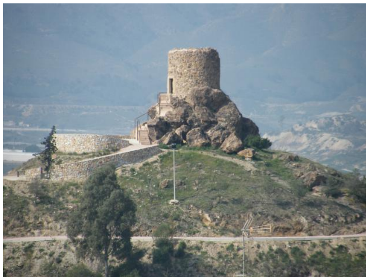
Figura 5. Torre del Molinete.
