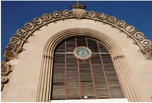
Figura 5. Detalle de la fachada del Mercado Municipal.
