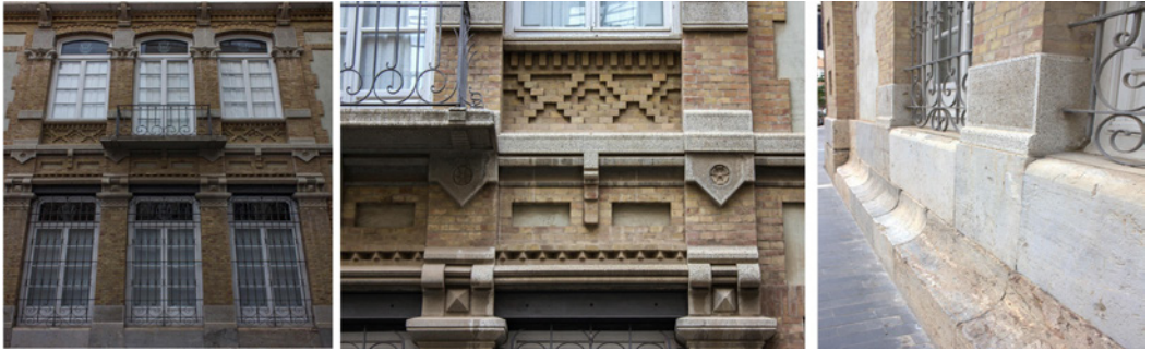
Figura 6. Detalle de fachada lateral (izq.) detalles de fachada principal (centro) y arranque de zócalo (dcha.).
