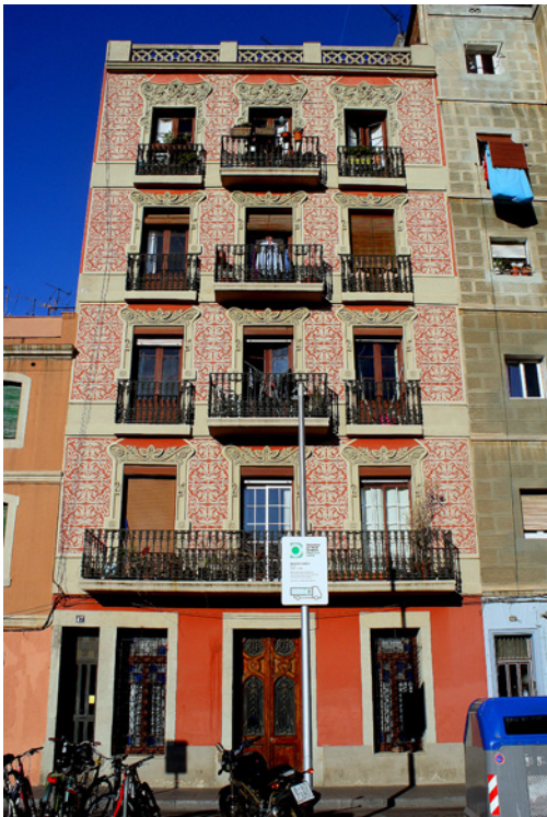
Figuras 1 y 2. Fachada principal y detalle del esgrafiado de la Casa Josep Magret (J. Graner, 1900).
