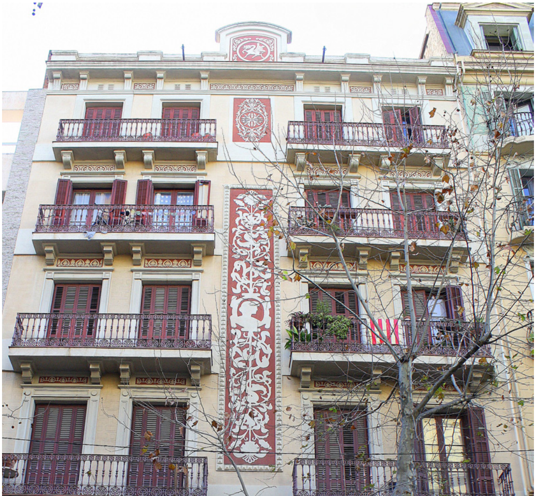
Figura 4. Fachada de la Casa Florentí Sánchez (J. Pérez Terraza, 1896-1898).
