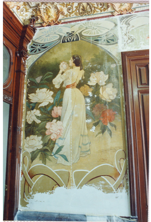
Figura 12 y 13. Proceso de empapelado de protección de la pintura para poder picar, sanear y enlucir los muros
