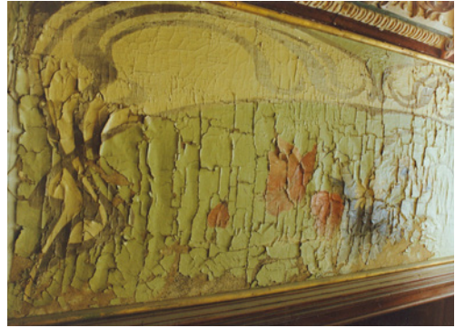
Figura 10. Imagen que muestra el lienzo encogido por el agua con la pérdida de pintura y el craquelado de todo el panel.
