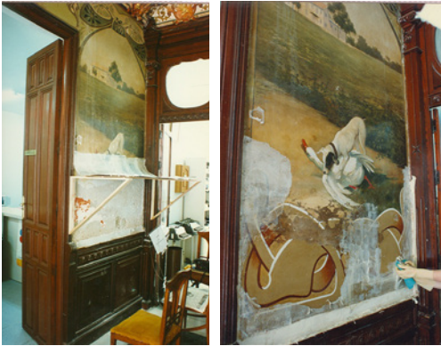
Figura 14 y 15. Colocación del lienzo sobre un soporte para sanear el muro y lienzo ya adherido con restos de protección.
