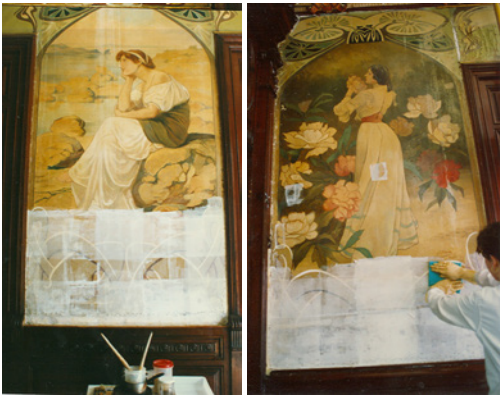
Figura 12 y 13. Proceso de empapelado de protección de la pintura para poder picar, sanear y enlucir los muros
