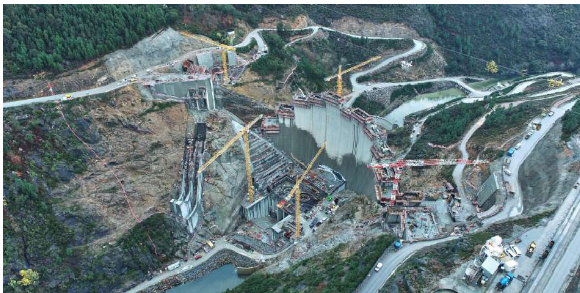
Figura 12. Presa de Alto Tâmega. Fuente: Iberdrola
