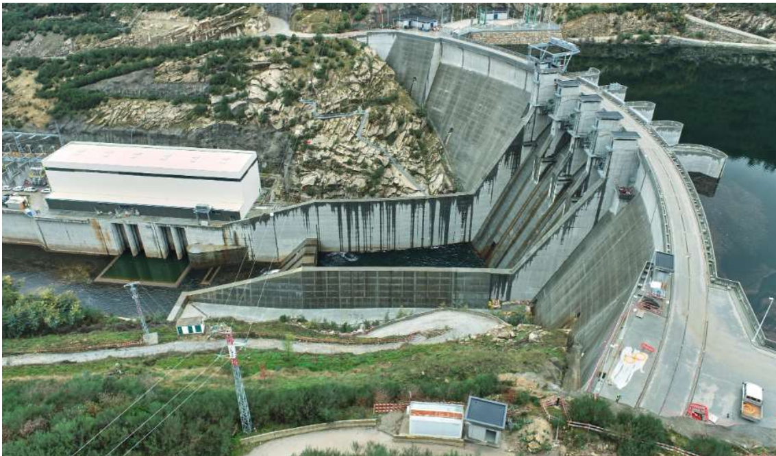
Figura 13. Presa de Daivões. Fuente: Iberdrola
