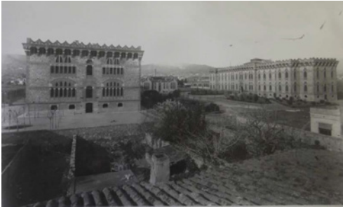
Figura 5. Barcelona. Barrio de Les Corts. Pabellones del Ave María y de la Lactancia de la antigua Casa de Maternidad y Expósitos, obra de Camil Oliveras, de 1888-1892. Foto: Archivo Mas, Barcelona. 1903.
