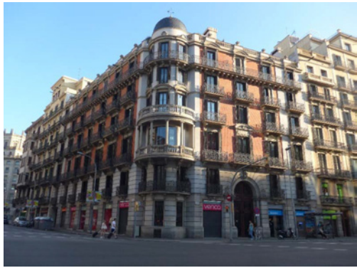
Figura 3. Barcelona. Casa Robert, conde de Serra, en la que se combina la piedra y el estuco con la obra vista. Joan Martorell Montells, arquitecto, 1893. Foto: R. Lacuesta, agosto 2016.
