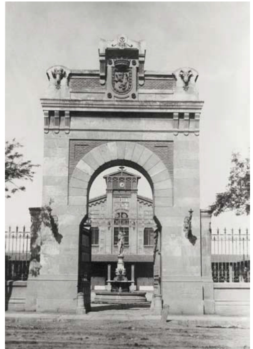
Figura 39. Zaragoza. Matadero Municipal. Ricardo Magdalena Tabuena, arquitecto. 1885. Foto: Archivo Municipal de Zaragoza.
