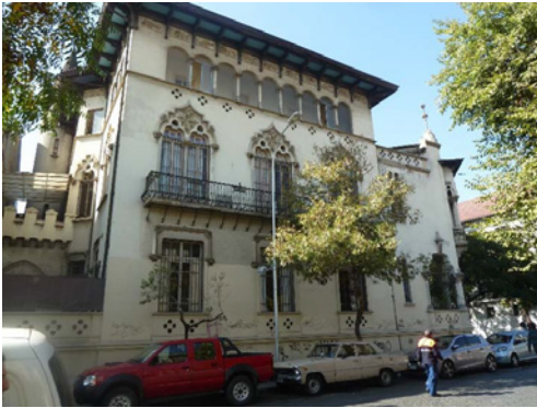
Figura 47. Santiago de Chile. Casa Letelier Llona, de 1919-1920 (actual sede de la Vicaría para la Educación del Arzobispado). Josep Forteza Ubach, arquitecto (Barcelona, 1863 – Santiago de Chile, 1946). Foto: Xavier González Toran, mayo de 2015.
