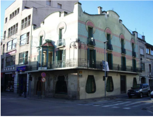
Figura 24. Granollers (Barcelona). Casa Blanxart. Jeroni Martorell Terrats, arquitecto, 1903-1907. Foto: Xavier González Toran, 2007.
