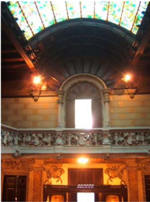
Figura 10. Barcelona. Detalle del vestíbulo del Palau de la Música Catalana. Lluís Domènech Montaner, arquitecto (1889-1893). Foto: R. Lacuesta, 2005.
