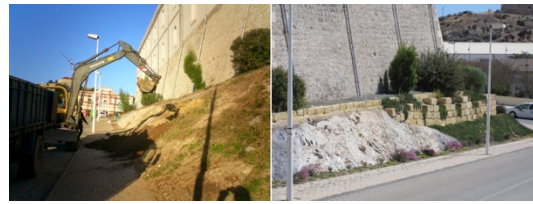
Figura 4. Acondicionamiento del talud
