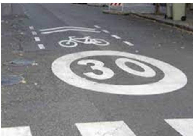
Imagen 16. Ejemplo de señalización horizontal de carril bici. Fuente: Google.
