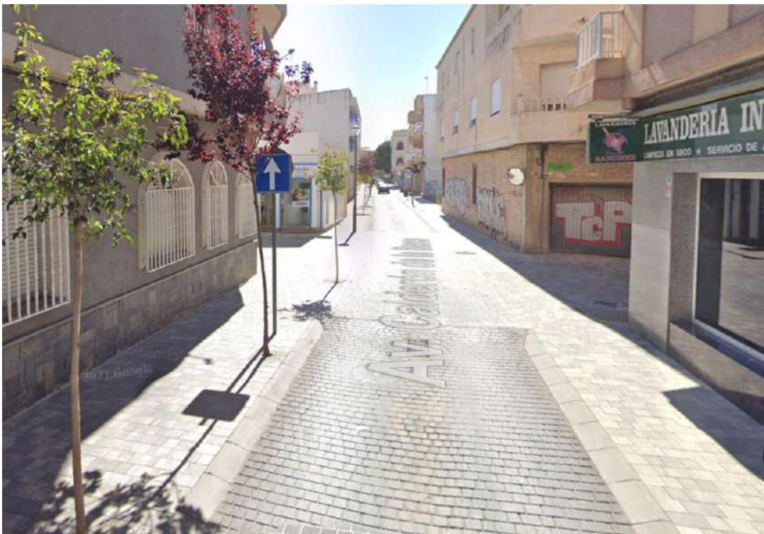
Imagen 5. Cambio de altura y adoquín en las intersecciones. Fuente. Google Earth.
