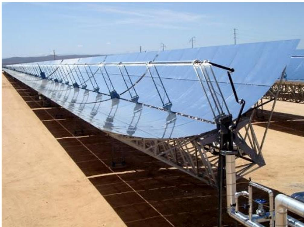
*Figura 7.- Reflector cilíndrico parabólico.*
