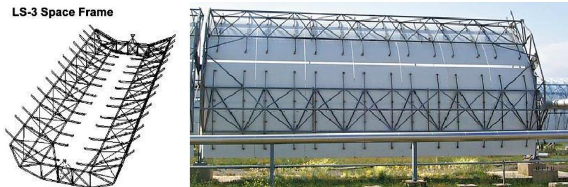
*Figura 6.- Estructura espacial de cerchas en V, colector LS-3 de Solel [10]*
