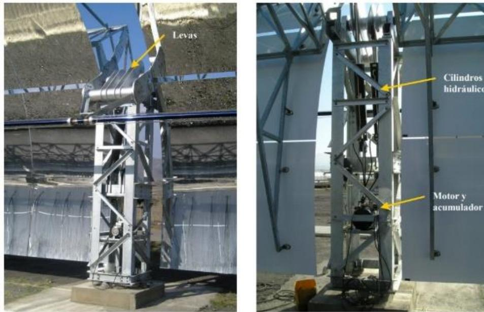
Figura 41.- Mecanismo de transmisión hidráulico.
