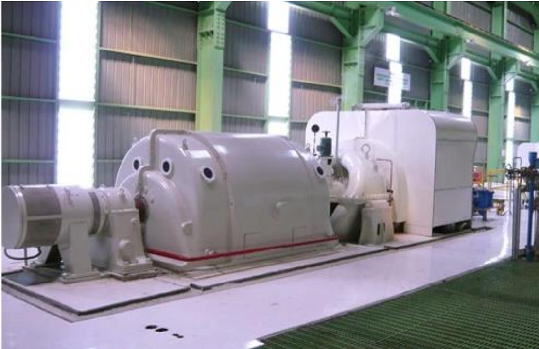
*Figura 25- Generador de turbina de vapor para centrales eléctricas. [20]*
