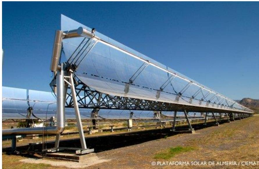
*Figura 5.- Sistema termosolar de CCPs de la planta termosolar de Almería*
