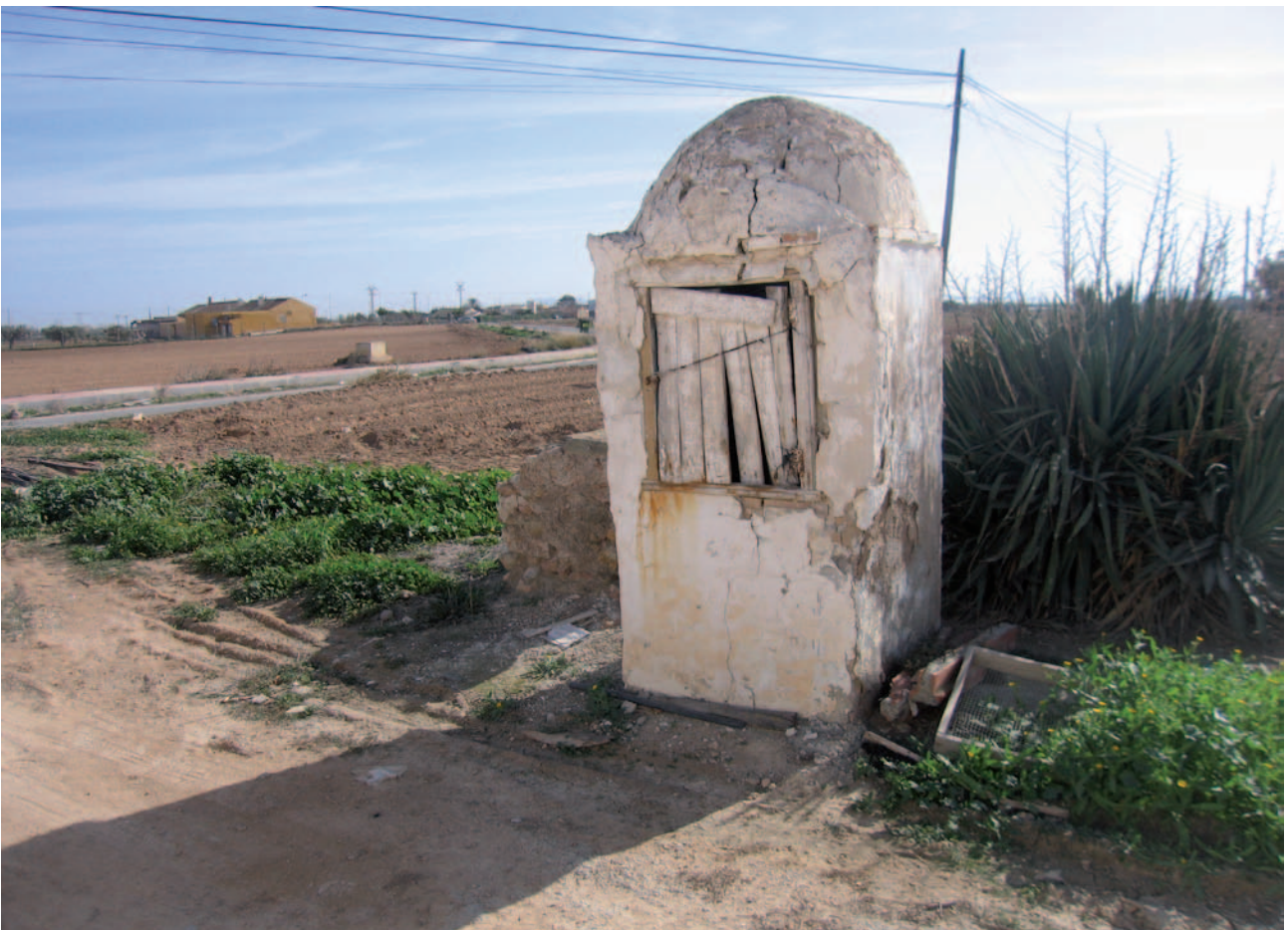
Fig.4 El tipo de aljibe más sencillo consiste en una vasija enterrada en forma de botella y escasa capacidad de almacenamiento de agua, cuya única parte visible es el cuello prolongado en el brocal. Paraje Los Conesas, Lobosillo.
