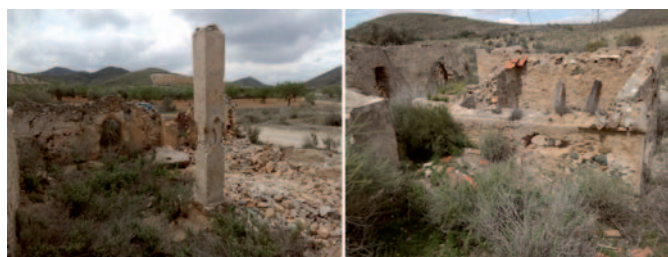
Figura 6. Restos de una era con el pilar central sobre el que giraba la bestia (izquierda). Almacén para el yeso molido (derecha).
