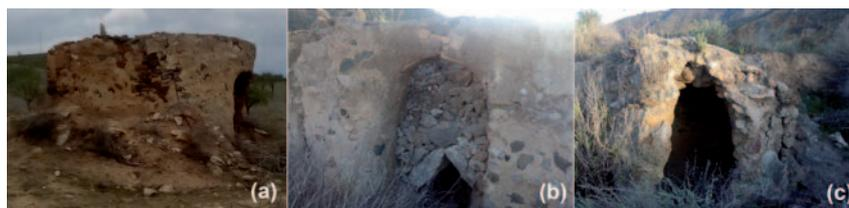
Figura 5. Horno para cocer el yeso (a). Piedras de yeso abandonadas colocadas para su cocción (b). Guarida y almacén para yeseros (c).
