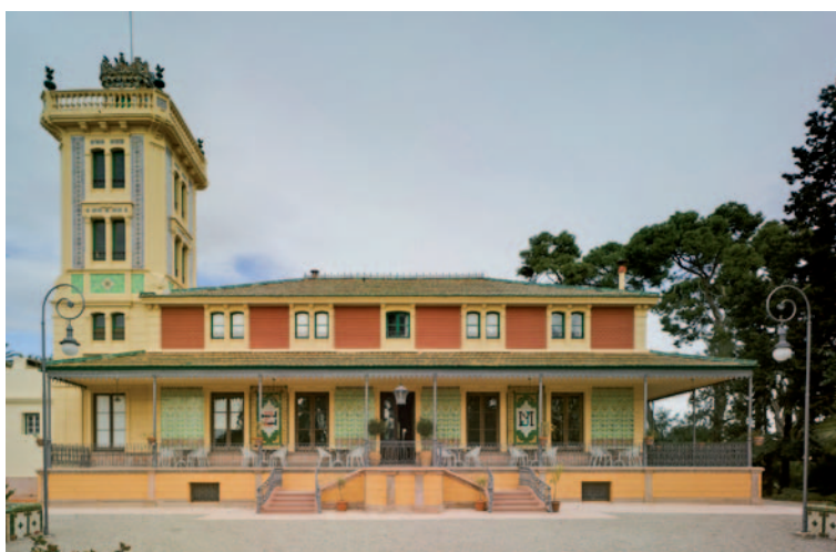
Figura 3. Torre Llagostera (El Plan). Fachada principal. Año 2015.
