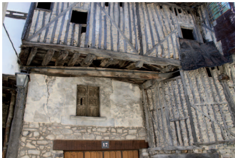
Figura 5. Tramonera en vivienda de Mogarraz
