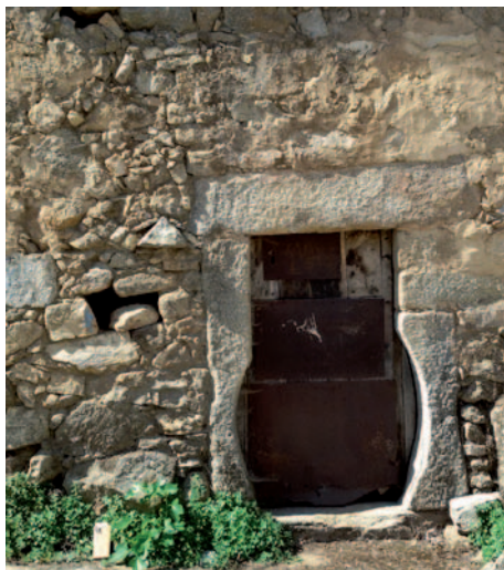
Figura 6. Puerta de una bodega y ventana de ventilación
