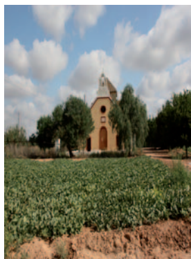
Figura 14. Fachada de la Ermita de Los Santos Médicos en los Segados.
