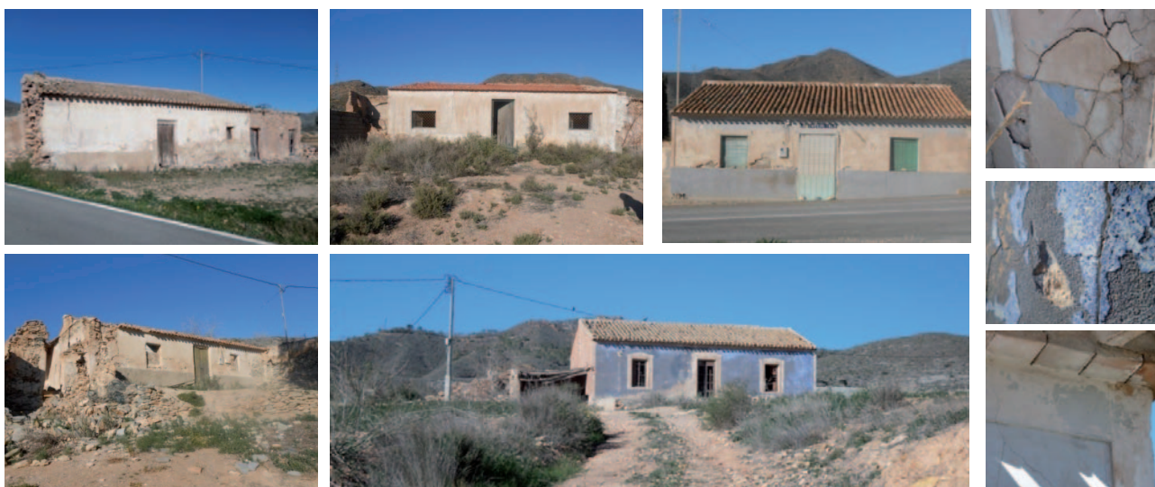
Figura 8. Viviendas analizadas en la rambla de Valdelentisco y detalle de las capas de revestimiento (Fuente propia)
