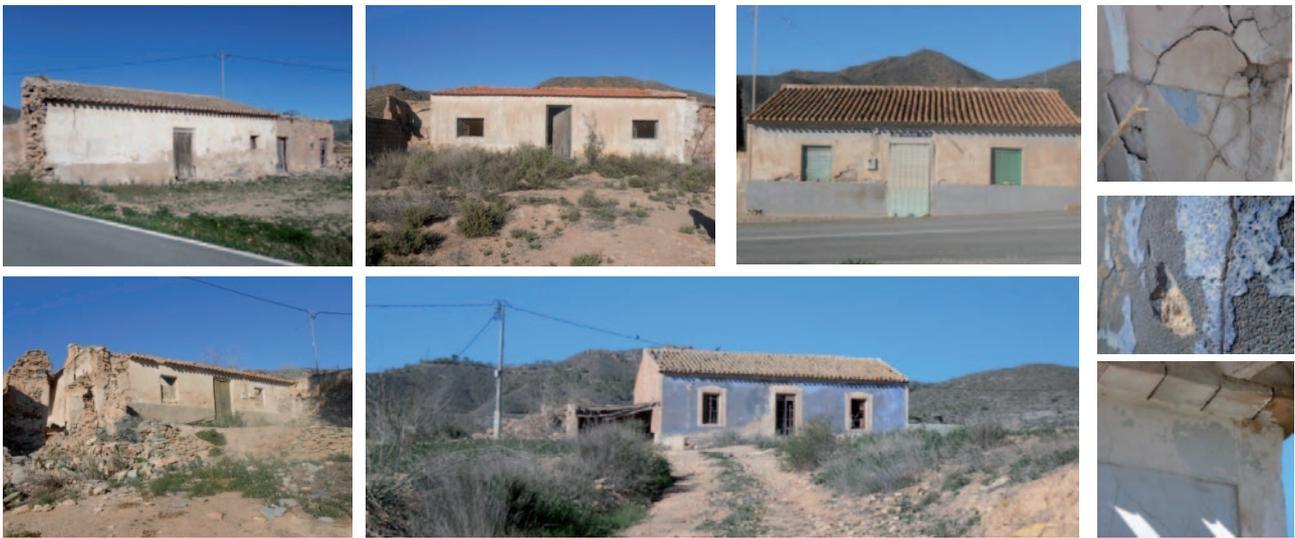
Figura 8. Viviendas analizadas en la rambla de Valdelentisco y detalle de las capas de revestimiento (Fuente propia)
