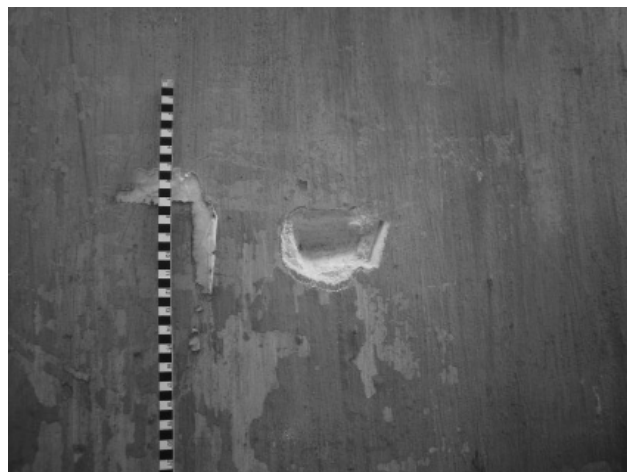
Figura 2. (La Spina) Fotografía que evidencia la toma de una muestra de revestimiento en una fachada del centro histórico de Valencia
