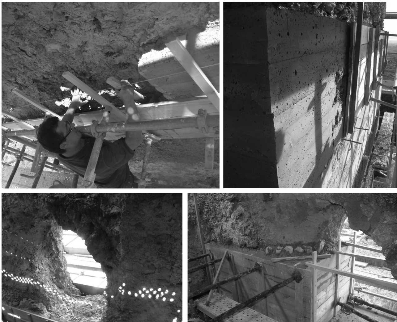
Figura 7. Imágenes de la utilización de la técnica del tapial para la reconstrucción de un muro en el Castillo de Carricola, encofrando a una sola cara y rellenando de tierra el espacio entre el muro antiguo y el encofrado. Las fotografías son reproducciones obtenidas en el Archivo correspondiente (Servicio de restauración de Bienes Culturales de la Diputación de Valencia).
