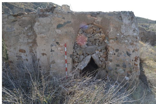
A. Horno circular cargado en la Rambla de las Yeseras de Mazarrón, Murcia.
