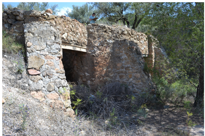
D. Hornos construidos de fábrica de mampostería con contrafuertes en Segorbe, Castellón.
