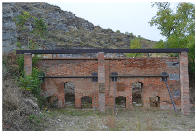
B. Hornos de planta rectangular, sección recta y frente cerrado con 3 aberturas en San Esteban de Litera, Huesca.
