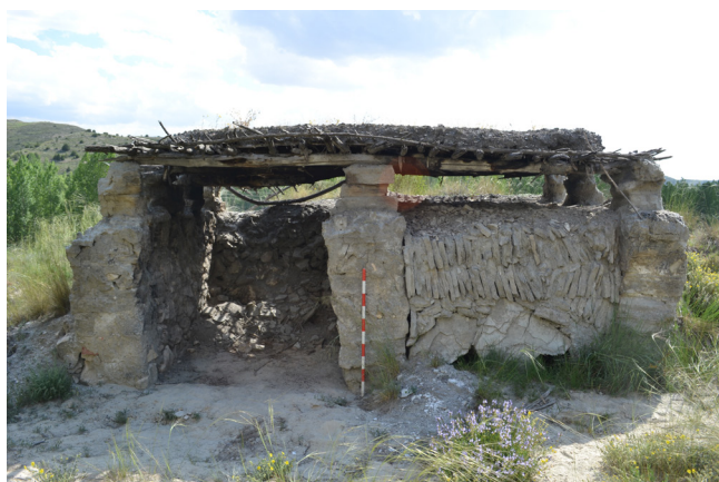
C. Horno de planta rectangular, sección recta y con cubierta en Navarrete del Río, Calamocha, Teruel.
