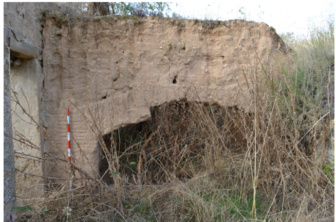
B. Horno semi-excavado de fábrica de adobe en Azanuy-Alins, Huesca.
