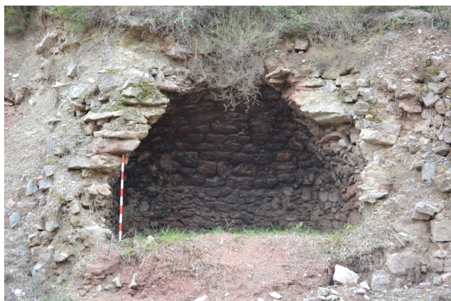
A. Horno de planta elíptica y sección troncocónica en Súrria, Barcelona.
