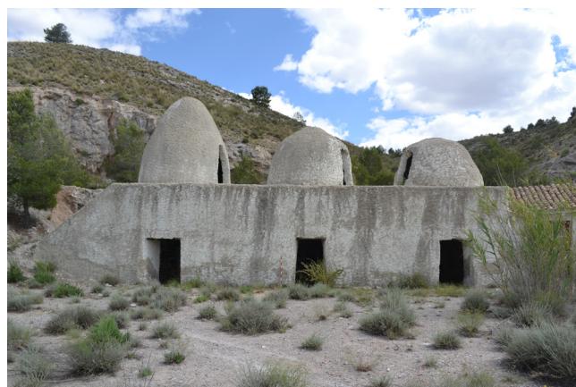
D. Hornos de planta circular, sección recta y cerrados en Villena, Alicante.
