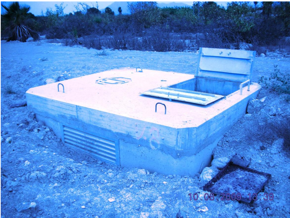
Ilustración 7 Arqueta Soterrada.
