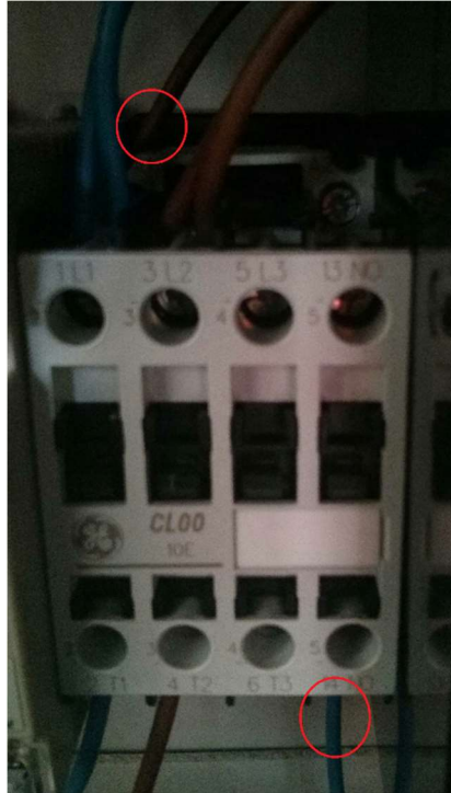
Figura 69. Alimentación del contactor 3.
