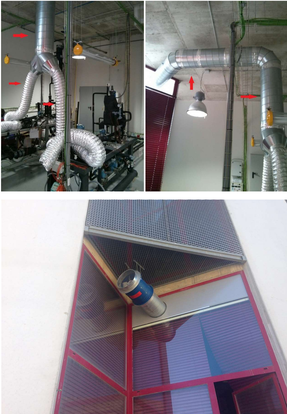
Figura 40. Sistema de extracción.
