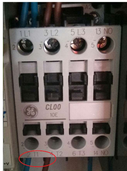
Figura 68. Conexión contactor 1 con contactor 3.
