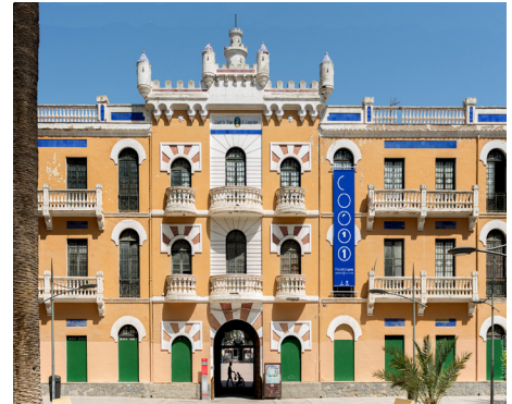
[FIG. 05]. ACCESO DESDE LA CALLE CARTAGENA AL PATIO DE ARMAS A TRAVÉS DEL PABELLÓN 1. FOTOGRAFÍA: JOSÉ LUIS CARRILLO, ARCHIVO PUERTAS DE CASTILLA.
