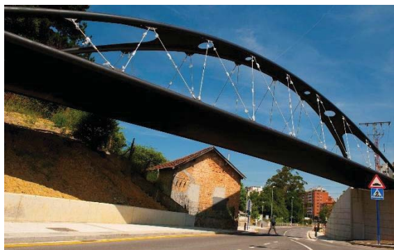
Fig. 2. Pasarela de Gorostiza (Barakaldo). En este caso la pasarela se compone de dos arcos tangentes en la clave, vinculados ambos al tablero con péndolas inclinadas tipo Nielsen. Fuente: [8].
