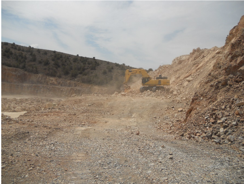
Imagen 7-2. La retroexcavadora sobre la pila de material a una altura aprox. de 3 metros, realizando el vertido del material al banco inferior.
