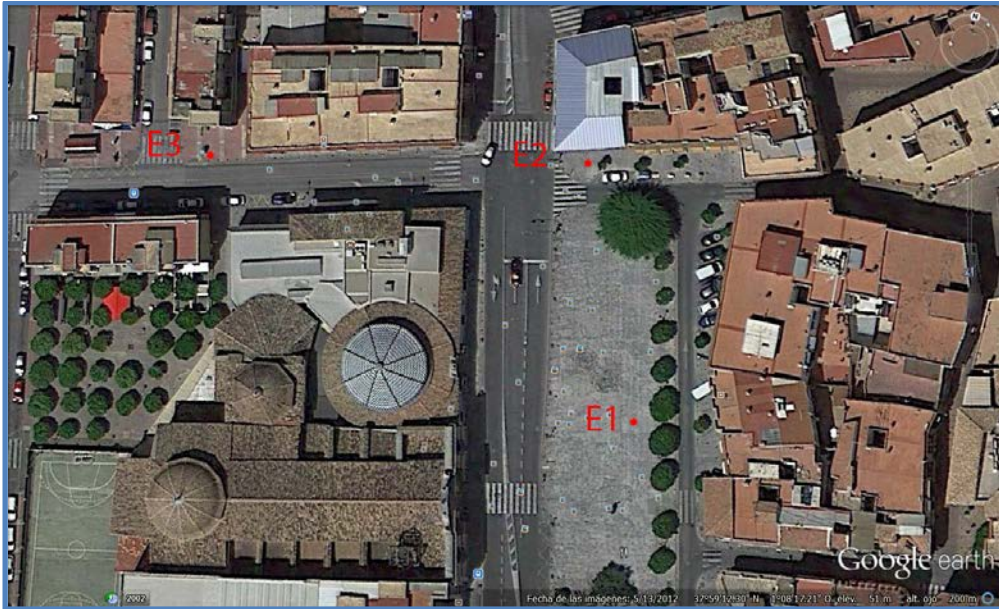
Aéreo del edificio (google earth).
