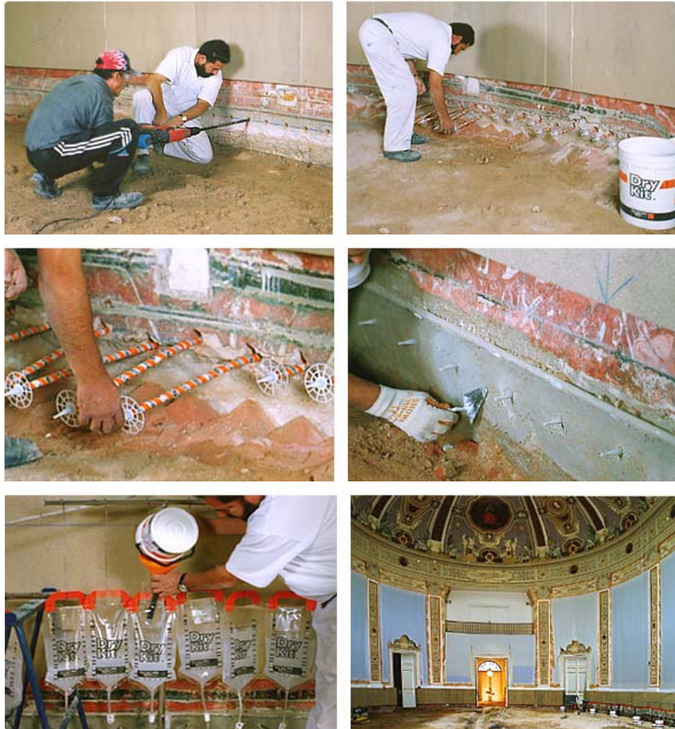
Aplicación del Sistema DryKit® en el Paraninfo de la Universidad Complutense de Madrid (dems)
