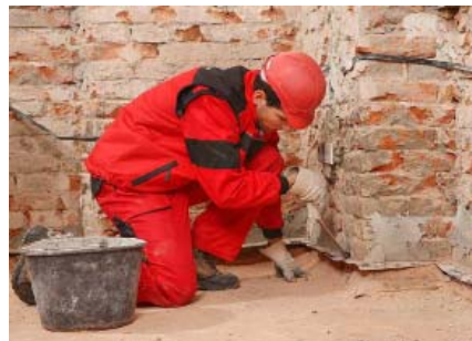
Fase 3.- sellado con mortero sin retracción
