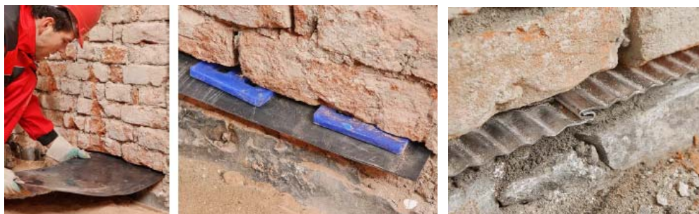
Fase 2.- introducción de la lámina impermeable (PVC)
