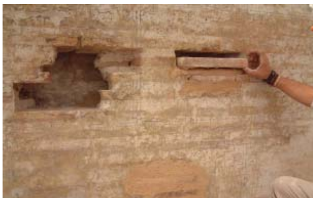
Sustitución de ladrillos
