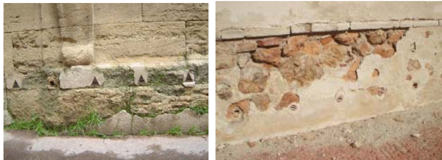
Curso superior en restauración y conservación de la edificación (2013). Tema 8: La humedad como patología de la edificación. Técnicas de tratamiento. Collado Espejo, Pedro Enrique
