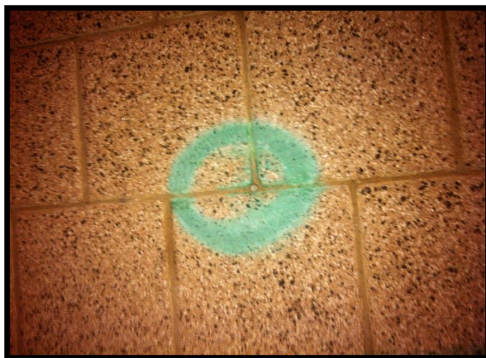
Imagen de la señalización de un punto
