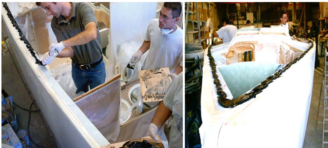
Figura 1.9: Aplicación de adhesivo.
