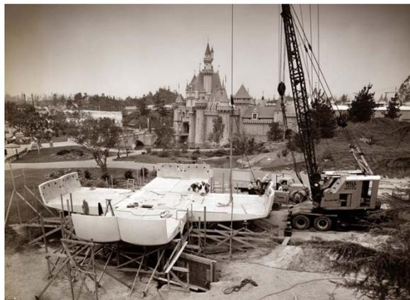
Con este diseño se demostró la capacidad estructural y la capacidad formal que se podría obtener con piezas prefabricadas de plástico, con voladizos de hasta 16 pies (4,80m aproximadamente) y capacidad de carga de 13 toneladas.
