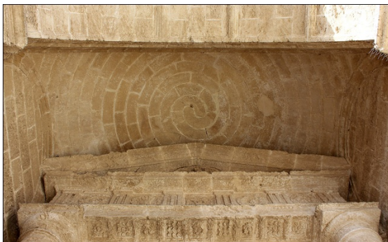
Fig. 1. Bóveda baída en el vestíbulo de acceso.
