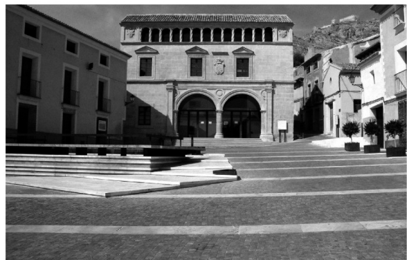
Fig.6. Estado de la Plaza de Arriba, tras su renovación.
