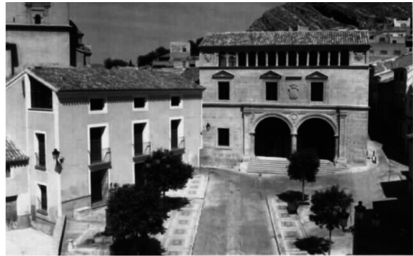
Fig.5. Estado de la Plaza de Arriba, antes de su renovación.
