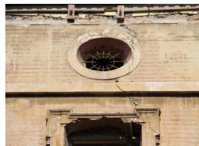
Fig. 1: Ejemplo de un revestimiento continuo histórico
