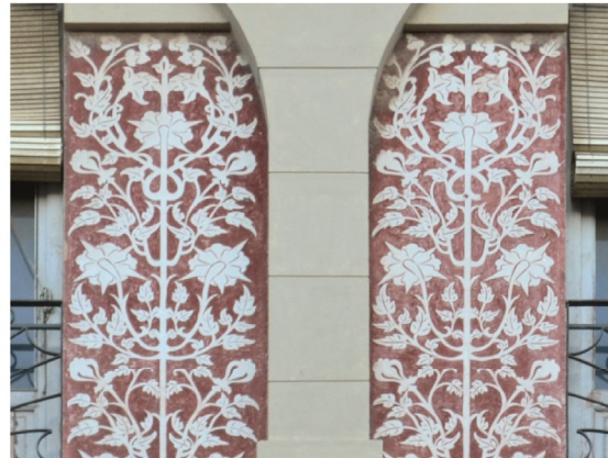
Fig. 2: Acabado superficial del revestimiento de una fachada
