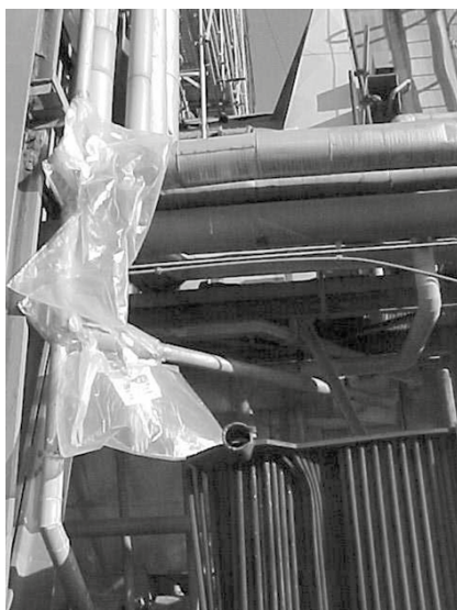
Figura 4. Trabajos sobre calorifugados con sacos con guantes “glove-bag”
