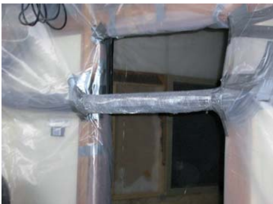
Figura A3.5 Protección de elementos
