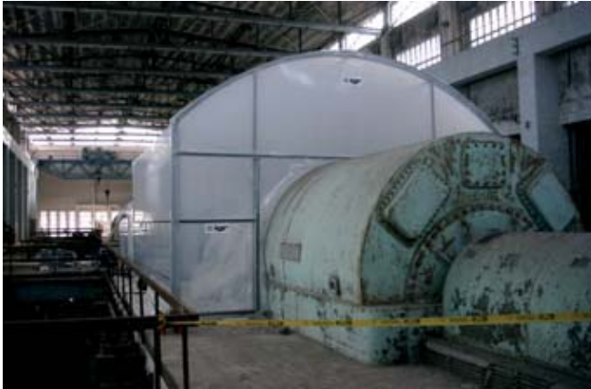
Figura A3.7a Burbuja para la retirada de los calorifugados De una turbina en una instalación industrial
