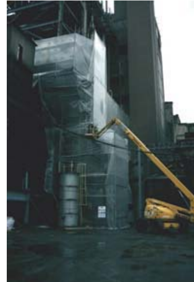
Figura A3.7b Burbuja para la retirada de calorifugados y otros MCA de una caldera en una central térmica
