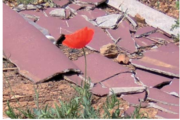
Figura A3.26b Residuos incontrolados de fibrocemento
