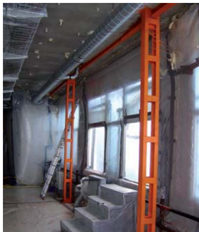
Figura A3.6 Barreras críticas
