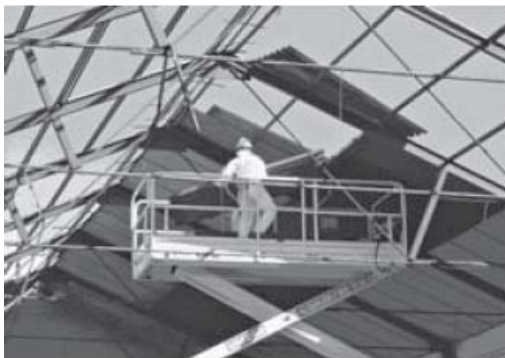
Figura 5. Exposición laboral: retirada placas fibrocemento
