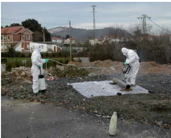
Figura A3.3 Ensayo de distintas herramientas de trabajo para corte de tubería.
