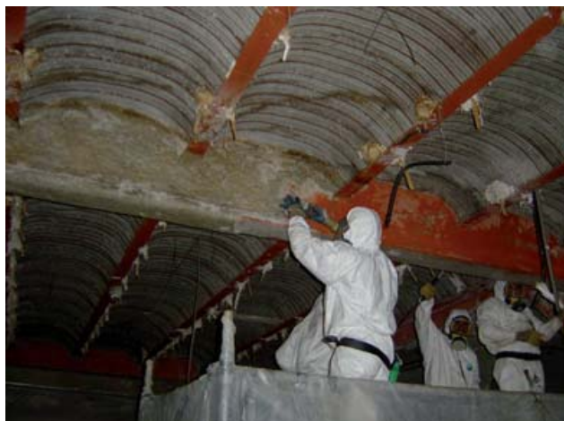
Figura A3.17 Retirada con herramienta manual (rasqueta) del recubrimiento ignífugo a base de mortero de amianto (MCA friable) en un edificio
