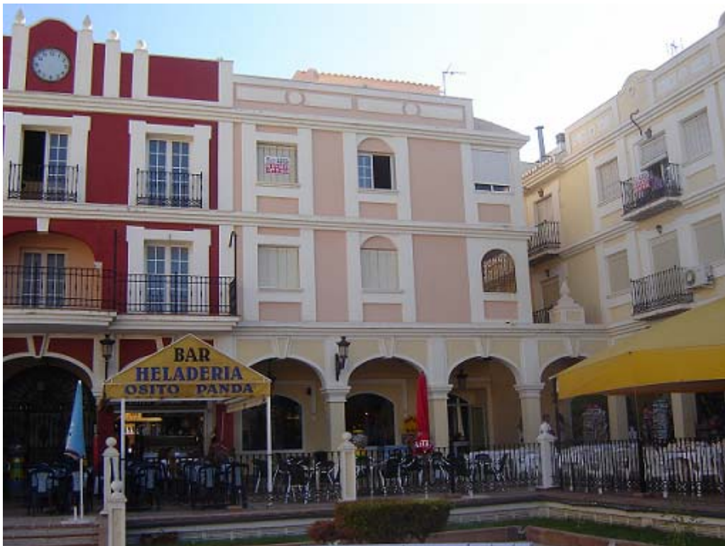
Fachadas con pintura plástica
