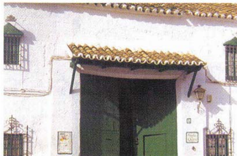
Puerta tratada con pintura al aceite
