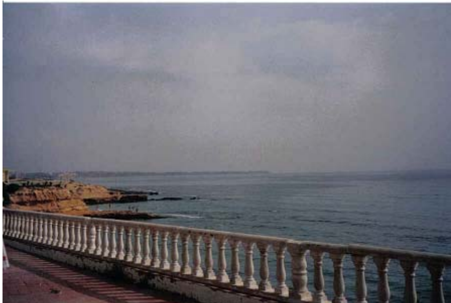
Soporte de barandilla pintado a la cal
