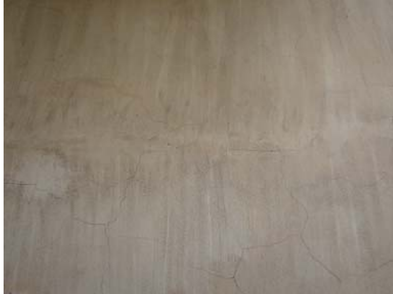
Muro con pintura al cemento
