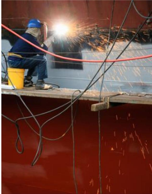
*Imagen 3. 5. Soldador trabajando en una postura incómoda y a varios metros de altura con riesgo de caída sin arnés de seguridad. Fuente: [32]*
