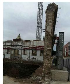
Muro de fachada sustentado mediante estabilizadores
