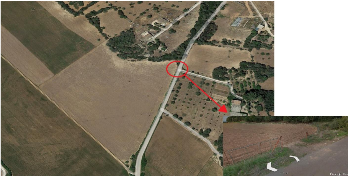
Ilustración 1. – “Acceso a la parcela. Fuente: Google Earth”.
