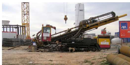
Fig. 6. Máquina de PHD; para la Desaladora del Nuevo Canal de Cartagena.
