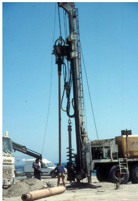
Fig. 4.- Sonda de rotación por circulación inversa y barrena helicoidal preparándose para la perforación del emboquille.
