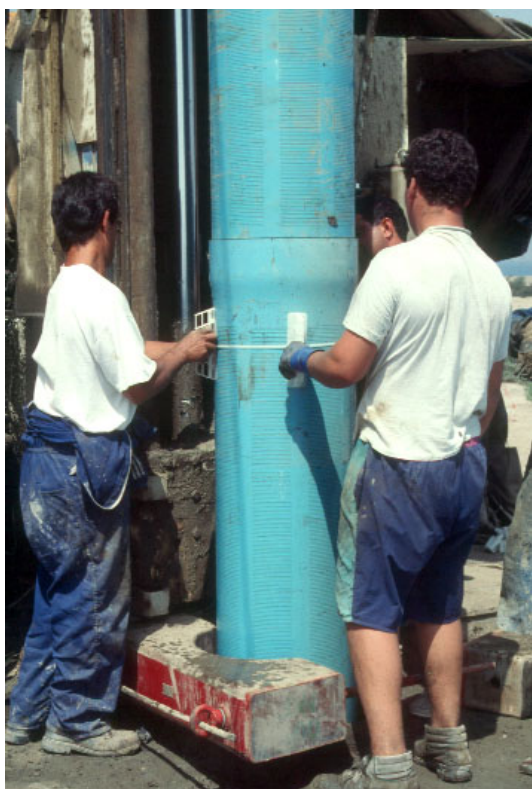
Fig. 5.- Colocación de una tubería plástica en uno de los sondeos de abastecimiento a la planta desaladora del Andarax.
