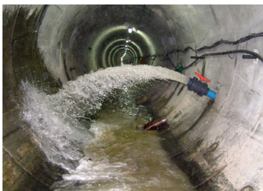
Fig. 8. Dren en el interior del túnel.
