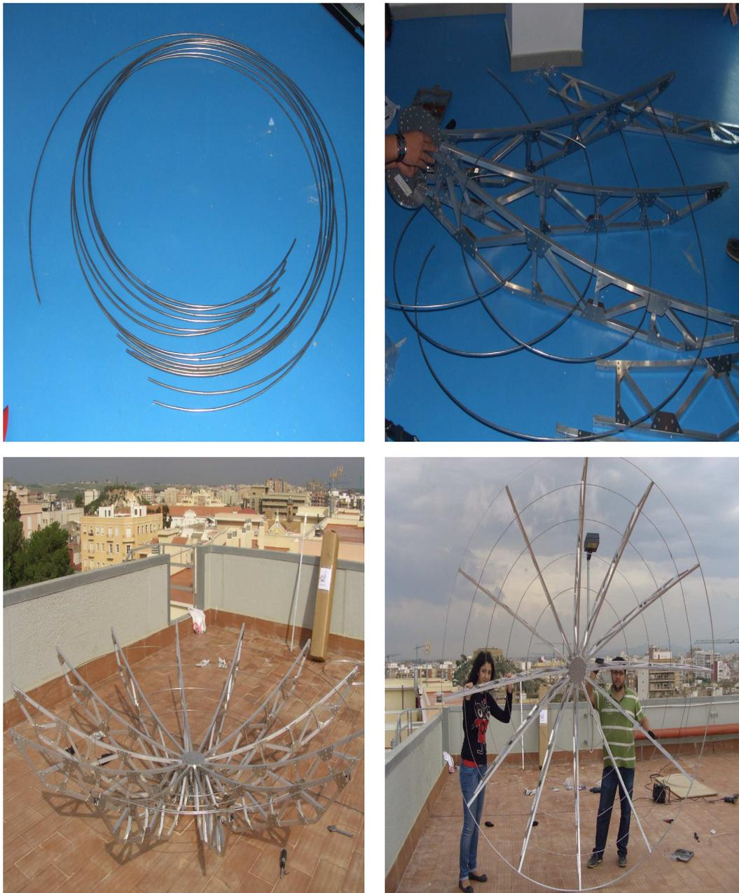
Figura 4.3: Colocación de anillos concéntricos que unen los brazos de la estructura del reflector
