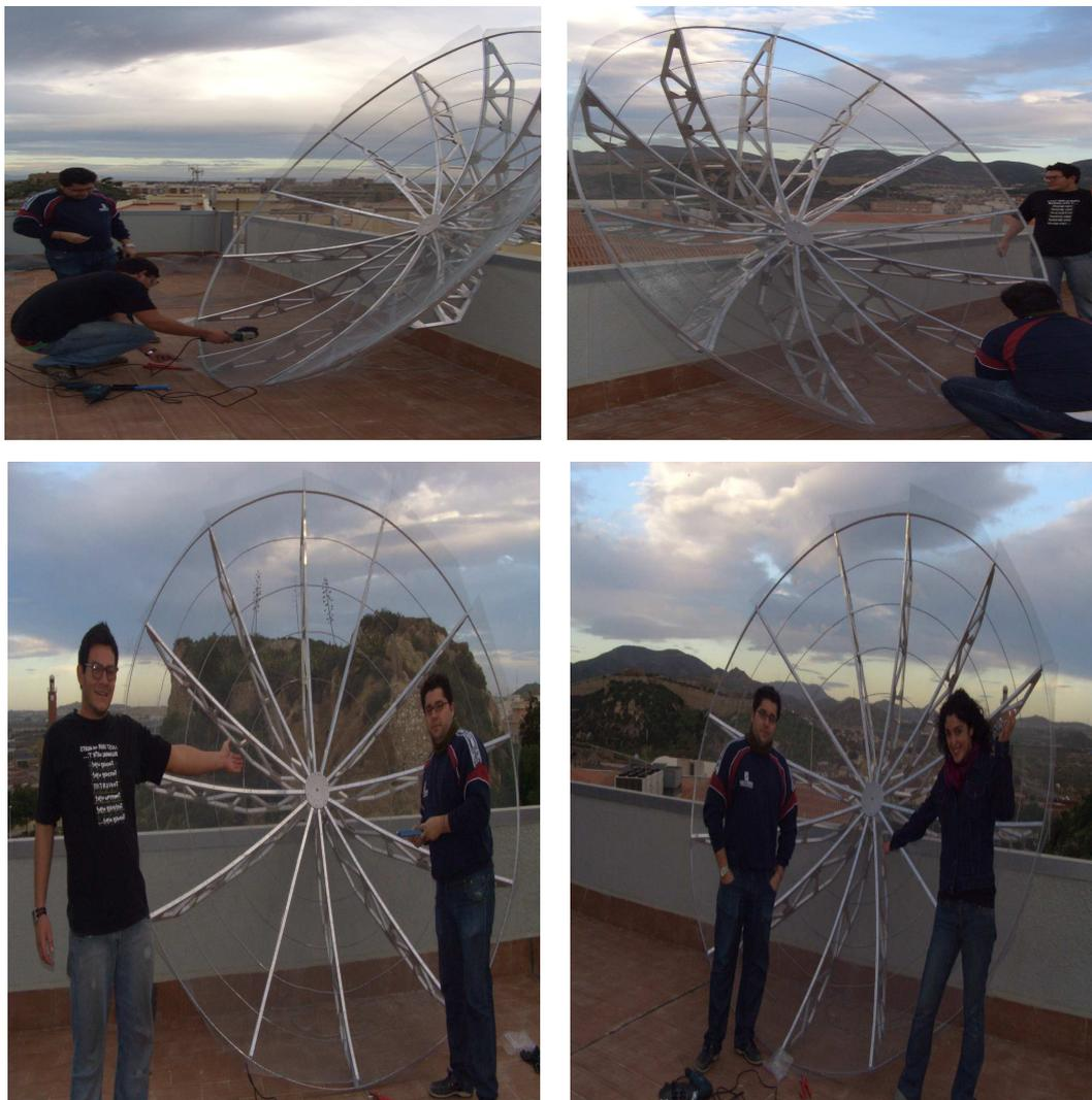
Figura 4.5: Aspecto del reflector con la superficie reflectora colocada
