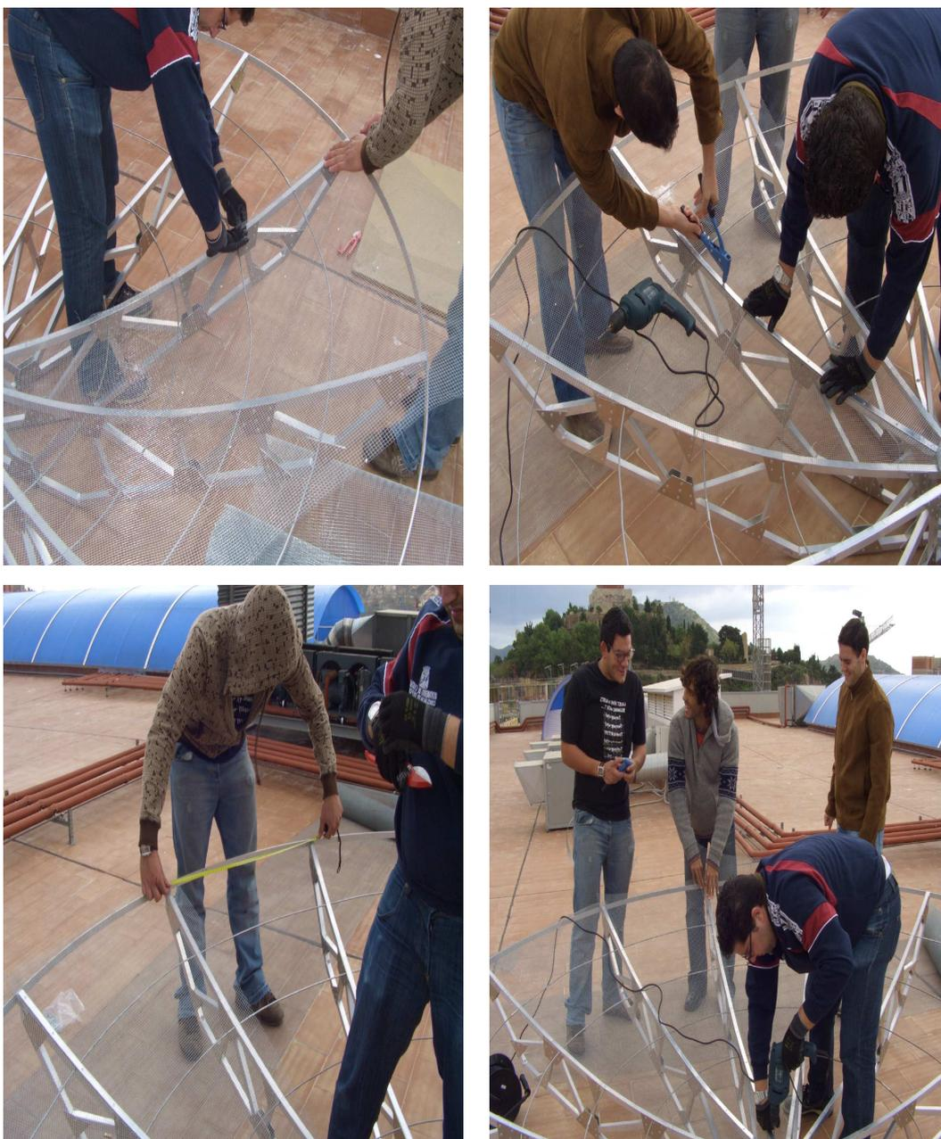
Figura 4.4: Colocación de la superficie reflectora
