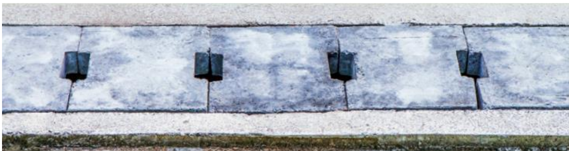
Figura 19 - Ejemplo de 'Sumidero Pluvial' al borde de la carretera. (Masseroni et al., 2018).
