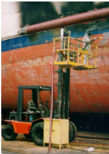
a) Operario chorreando
