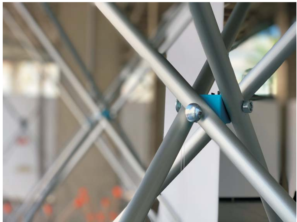
4.2_Estructura: la propia estructura soporte de los paneles y las maquetas es una estructura desplegable basada en el módulo de 4 barras de Emilio Pérez Piñero. Está construido con barras de aluminio y nudos de plástico ABS con impresión 3D.
