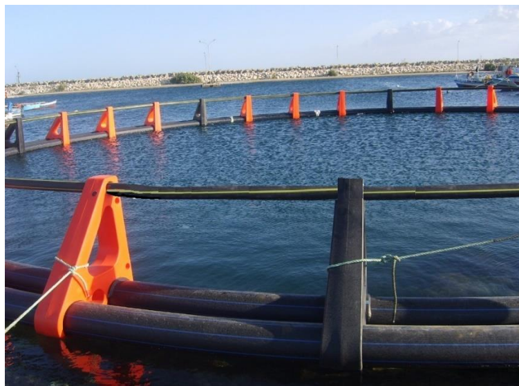
Imagen 5-6. Estructura de sustentación y flotación. Fuente: Desconocida
