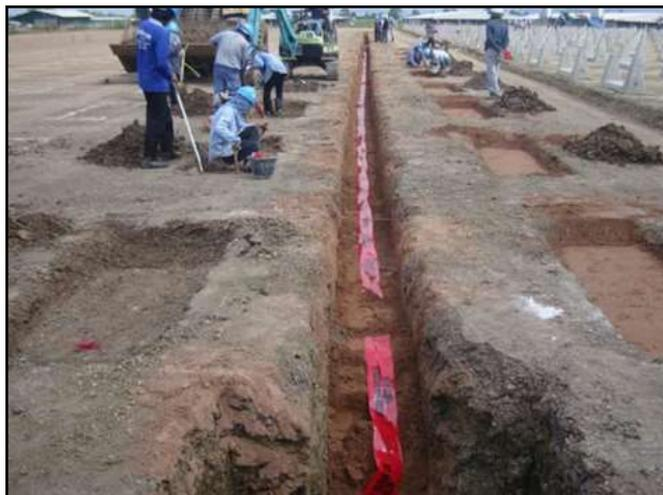
*Figura 4: Colocación cinta protectora*
