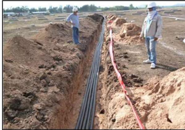
*Figura 3: Instalación de cables*
