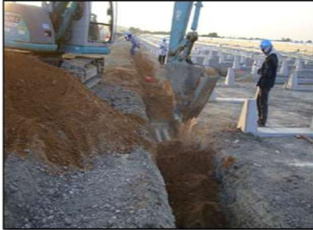
*Figura 5: Recubrimiento de arena*
