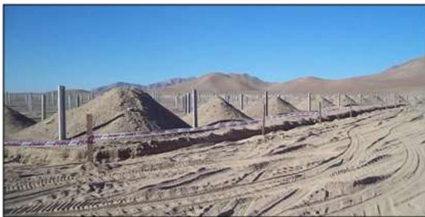
*Figura 6: Señalización de las zanjas con cintas de peligro*
