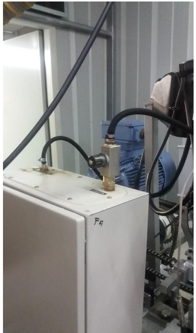
Ilustración 1.5.4.2. Instalación del medidor del flujo másico sobre la bancada.
