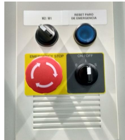
Ilustración 1.1.2.4. Seta de emergencia y botonería de rearme del armario de potencia.
