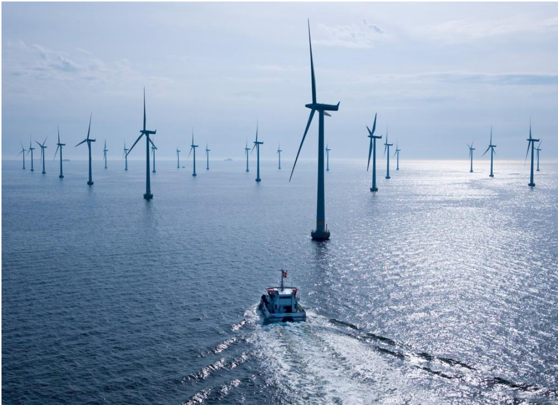
Figura 2 – Parque eólico marino
