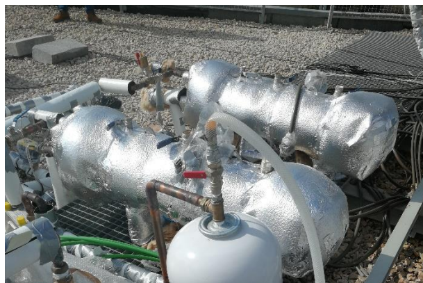
Figura 37. Acumuladores de calor latente y sensible con PCM
