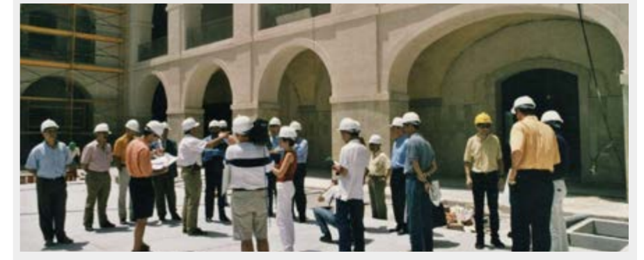
1999 Visita a las obras de rehabilitación de la Escuela de Industriales, antiguo Hospital de Marina.
